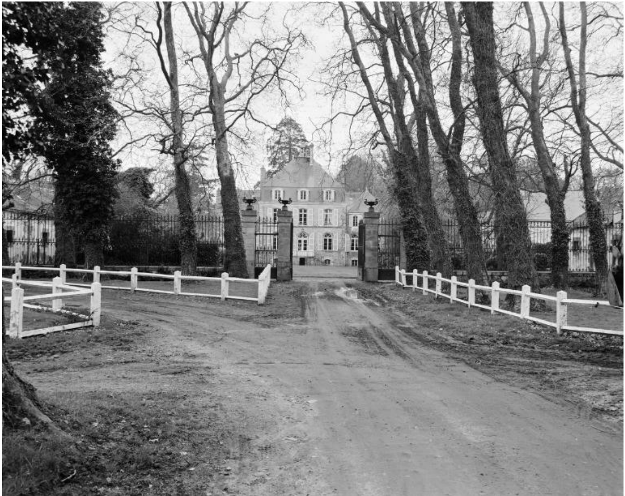
Vue de situation prise du nord.
