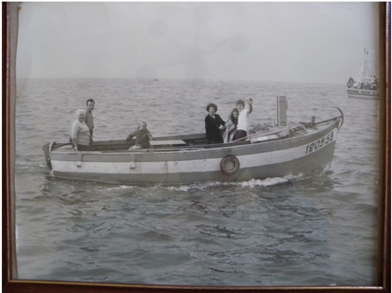
Vue du petit chalutier demi-ponté 'Marie-Josée 1', 20 pieds de long, avec mât à bascule, construit par le chantier Lanier à Saint-Malo (collection particulière)
