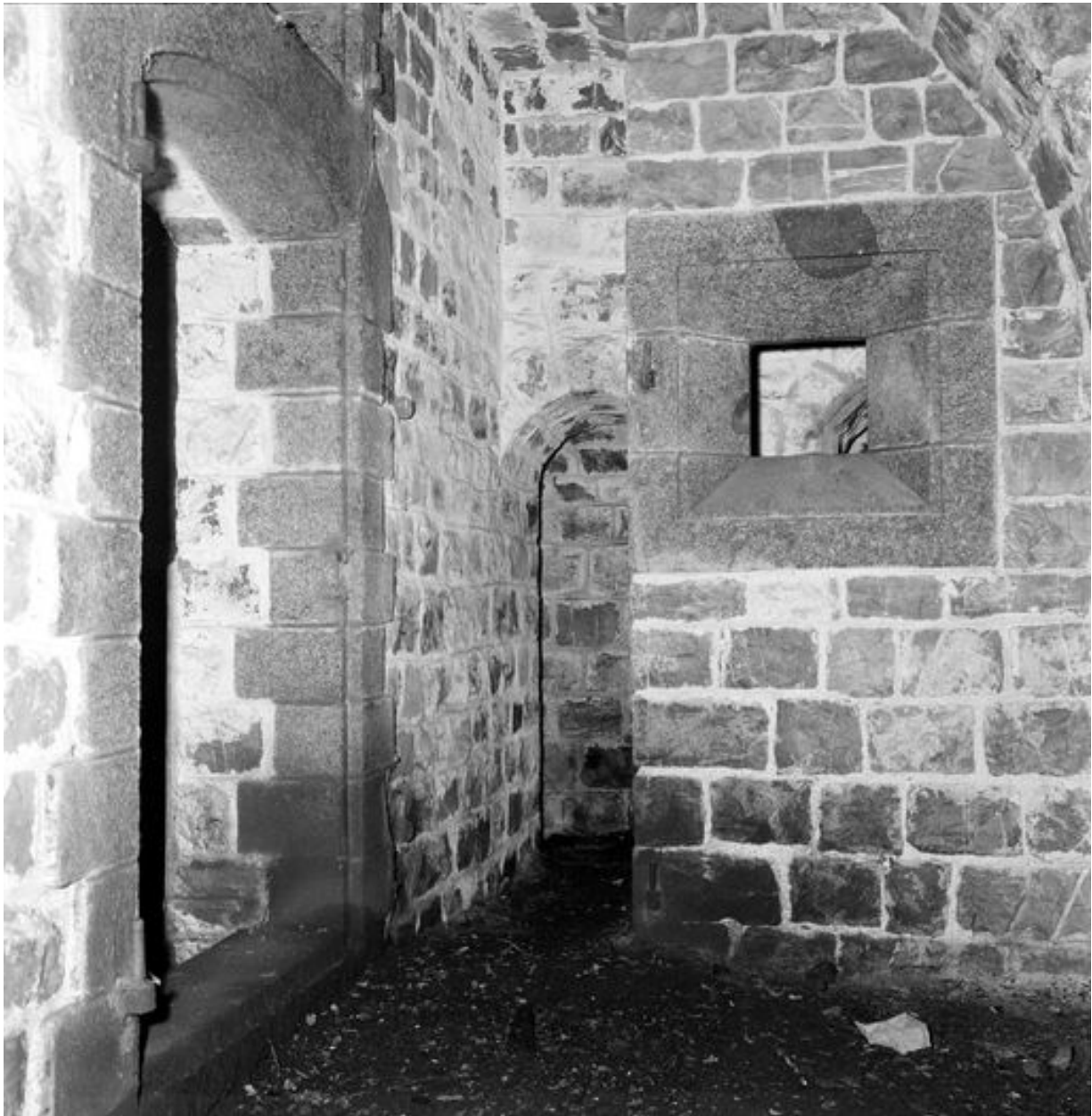
Vue du réduit de Landaoudec en 1969 : vestibule du magasin à poudre. A gauche : entrée de la chambre des poudres, au centre : départ de la galerie enveloppe, à droite : logement de lanterne dit créneau de lanterne
