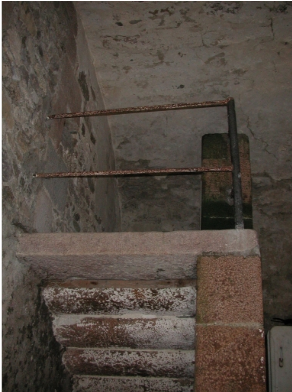
L'escalier de distribution intérieure en granite
