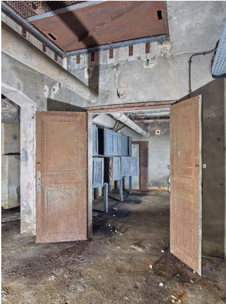
Vue du sous-sol de la salle des groupes électrogènes diesel : extrémité ouest, pièce abritant un ensemble d'armoires d'atelier avec leurs outils et accessoires pour machine-outil
