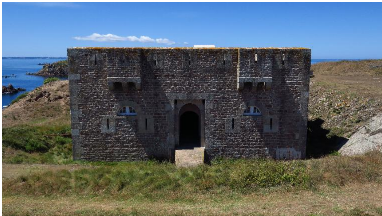
Île-d'Houat, batterie du Béniguet, corps de garde crénelé, façade est.
