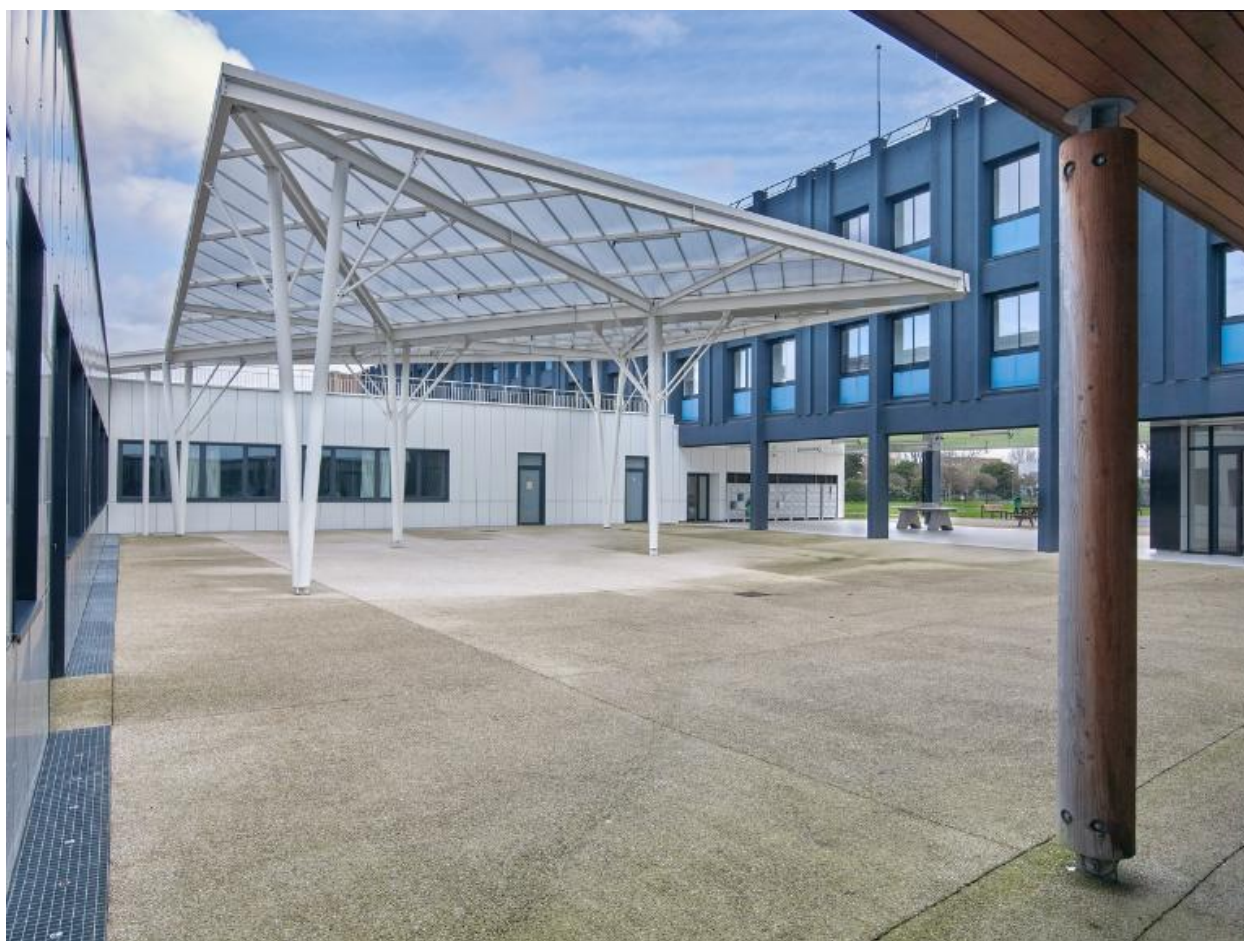
Agora. vue prise du nord-ouest, vers la façade est du nouveau bâtiment. Pierre Brulé, architecte 2021. Noter le chéneau, en diagonal, qui donne une "queue", à la "raie manta".
