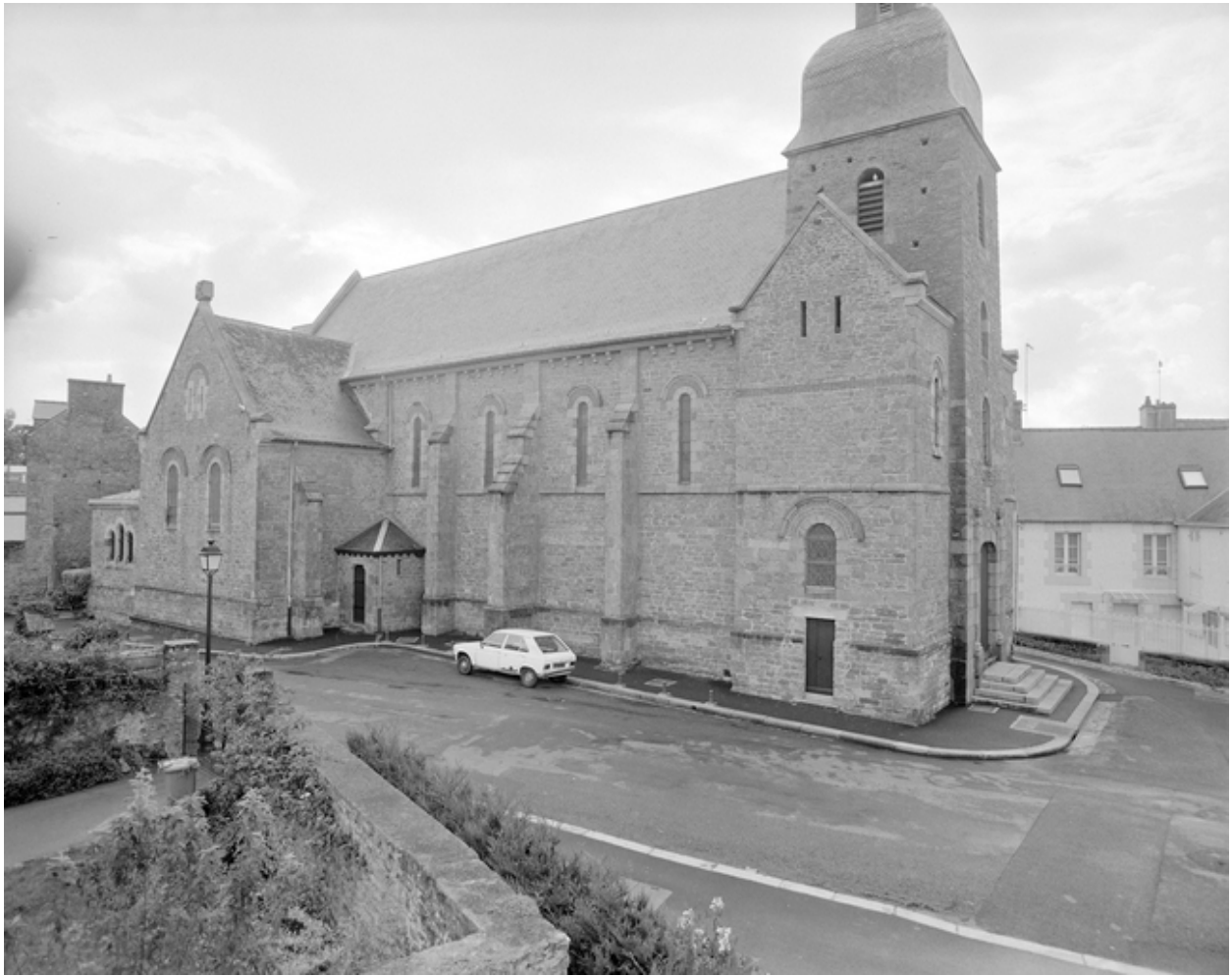
Elévation Nord : vue générale.
