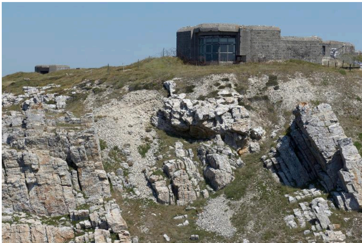
Vue du bunker - casemate sud abritant le Musée mémorial de la bataille de l'Atlantique
