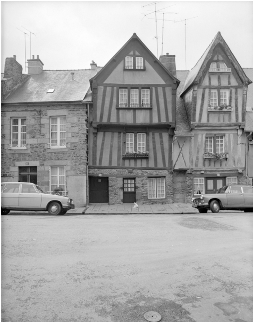
Vue générale de l'élévation antérieure.
