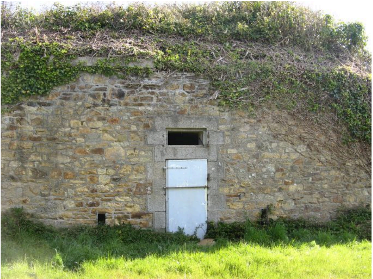
Elément de la batterie de Pont-Scorff
