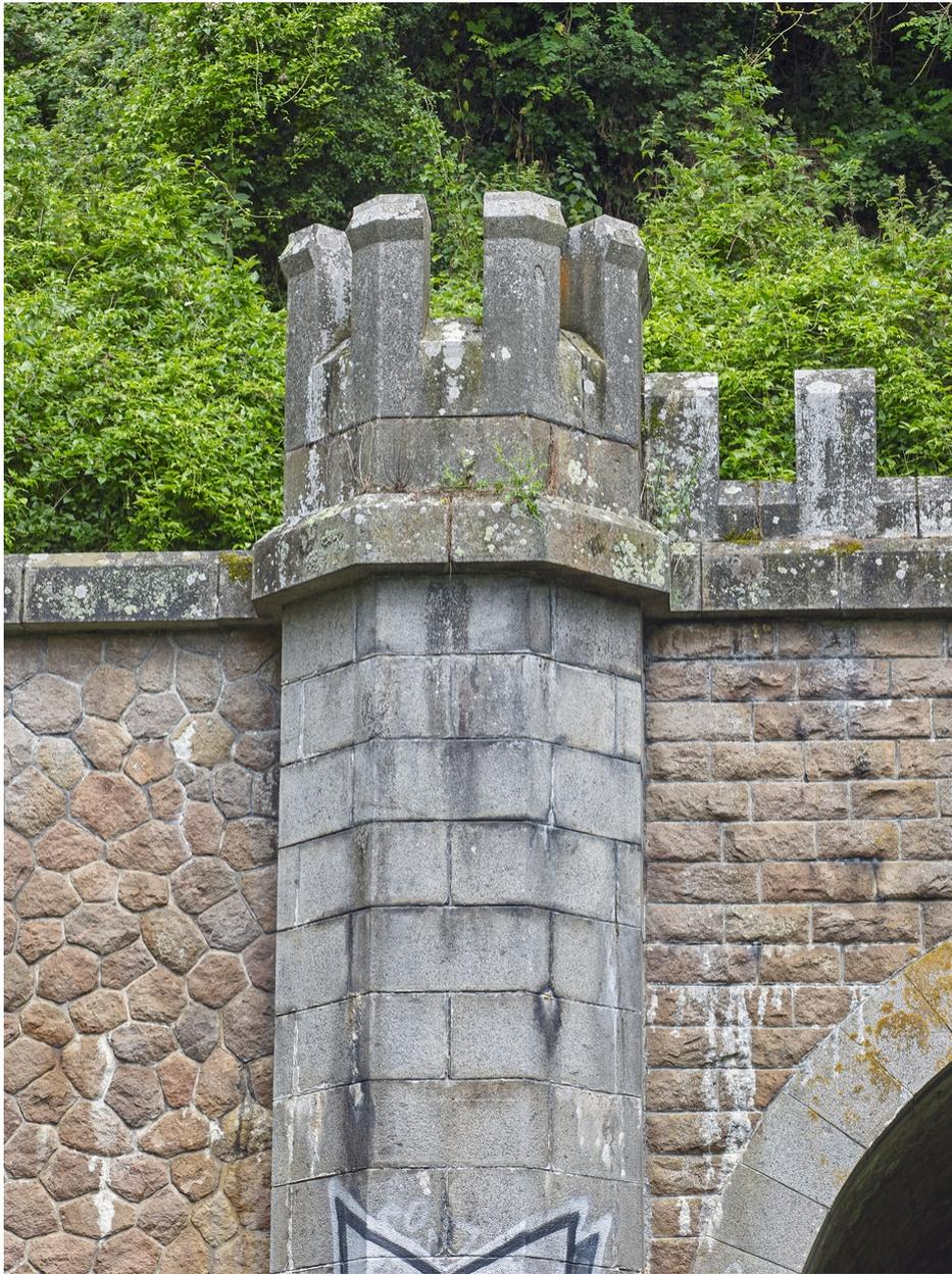
Vue de l'entrée côté Port du Légué dans le style néo-gothique : appareillage polygonal en granite rose à la face brute, tour - pilastre crénelée décorative en pierre de taille de granite gris et appareillage en moellon équarri de granite rose. Arc de voûte et tablette sont en granite gris
