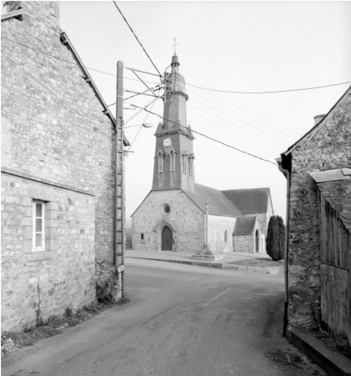
Elévation Sud-Ouest : vue générale
