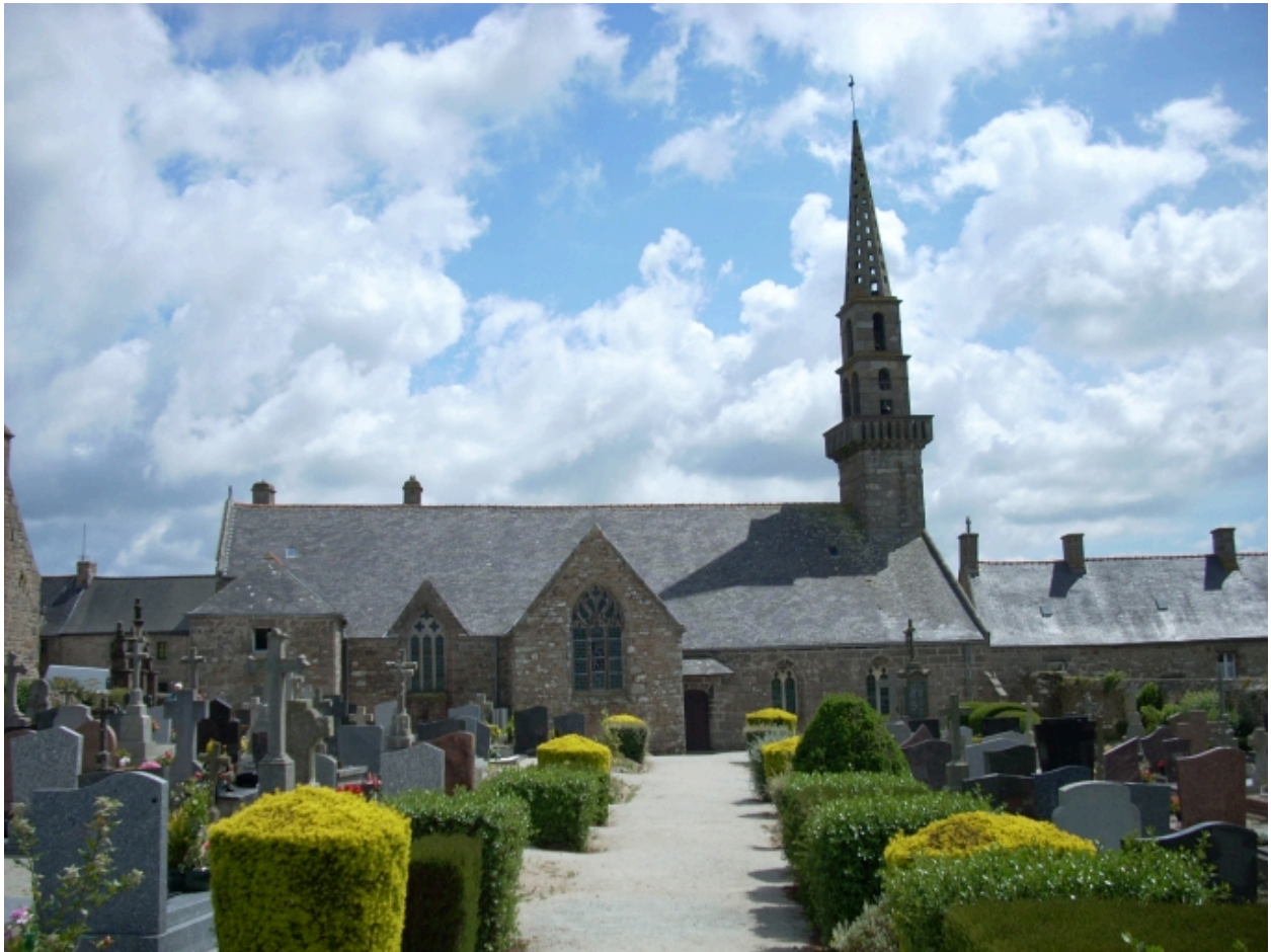
Brélès, église paroissiale : élévation nord
