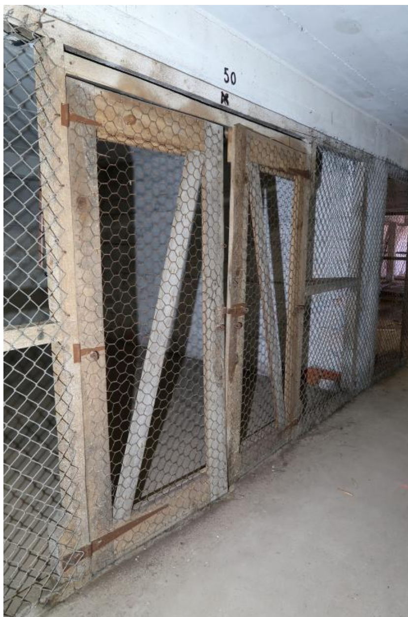
Deuxième étage : box 55 avec ses portes d'origine (pentures, ferrures et dispositifs de fermeture)
