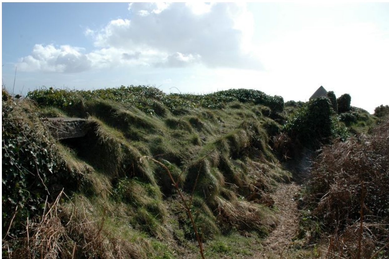
Vue de l'ensemble fortifié de Porsfeunteun : ouvrages allemands envahis par la végétation
