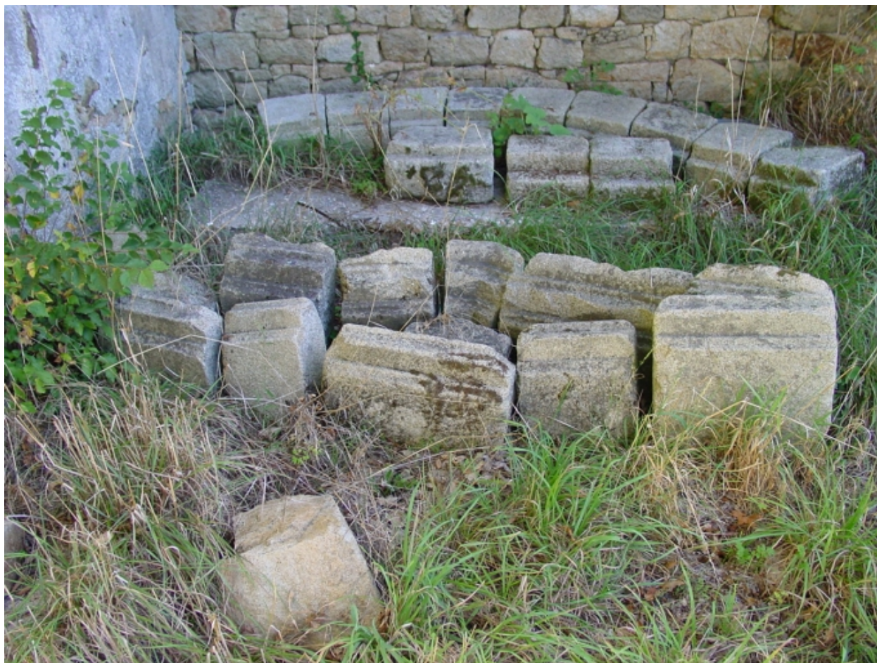
L'orangerie, vestiges d'un fronton de l'une des baies déposés au pied de la façade sud.
