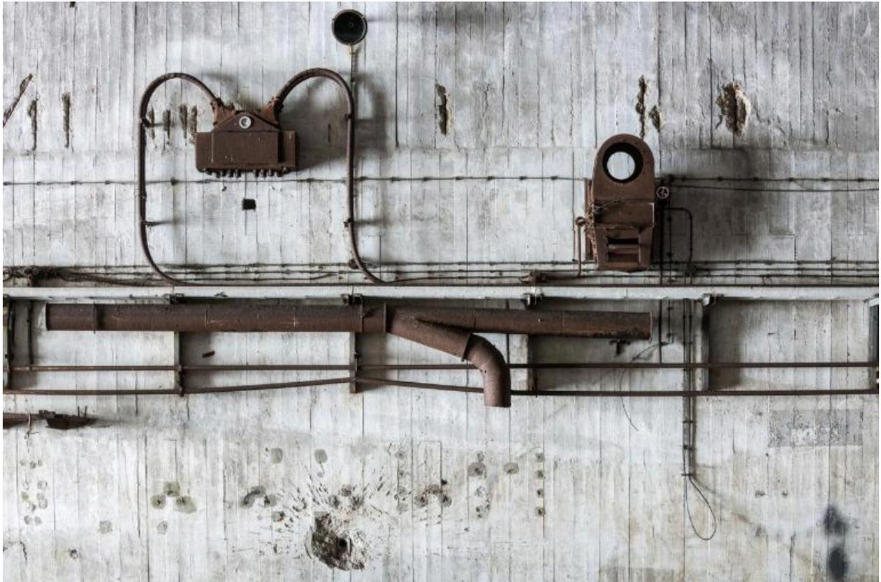
Vue du système de chauffage et de ventilation et du chemin de câble fixés au mur nord de l'alvéole nord
