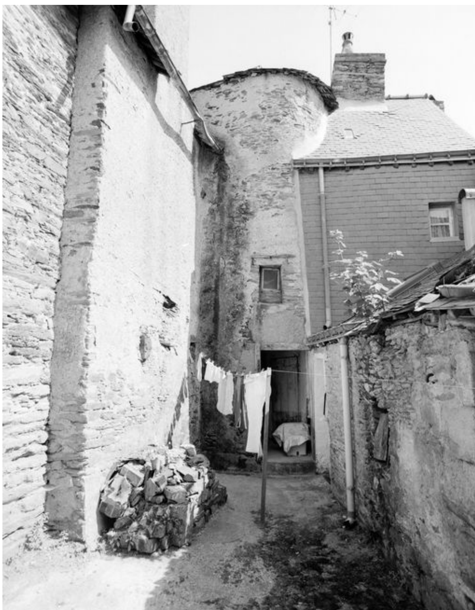
Maison de commerçant : élévation ouest sur cour (état en 1992)
