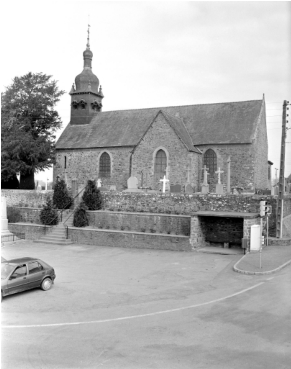
Elévation Sud : vue générale
