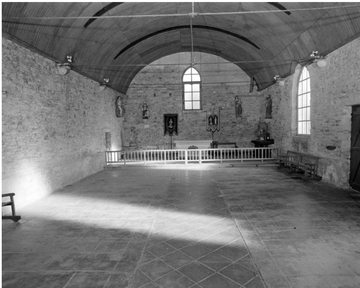
Vue intérieure vers l'est.
