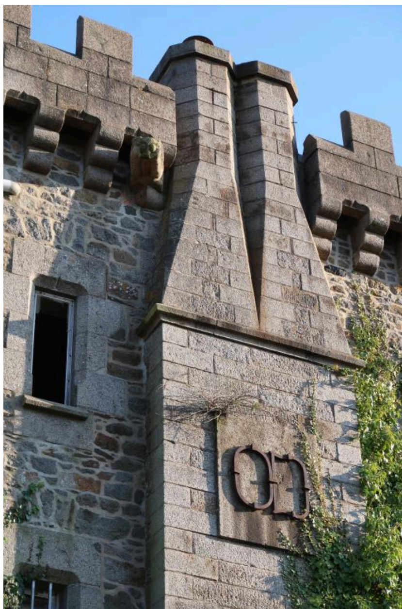
Vue de détail de l'élévation orientée vers l'ouest-nord-ouest
