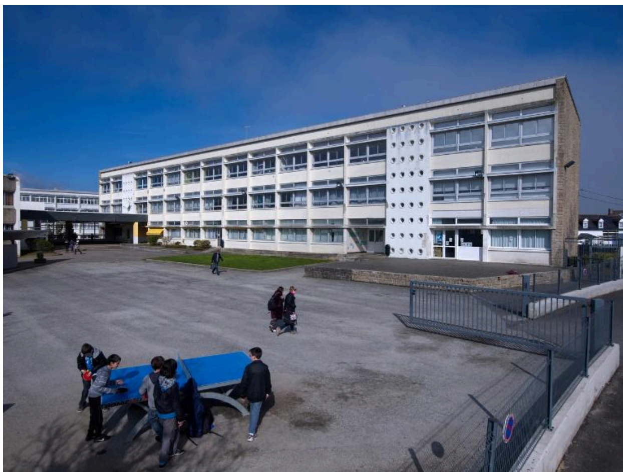
Externat, façade sud. Raymond Lopez, architecte, 1958.
