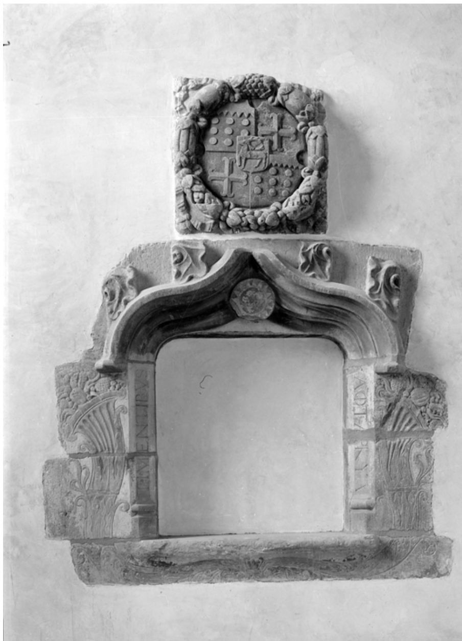
Chapelle, deuxième niveau, détail du mur est.
