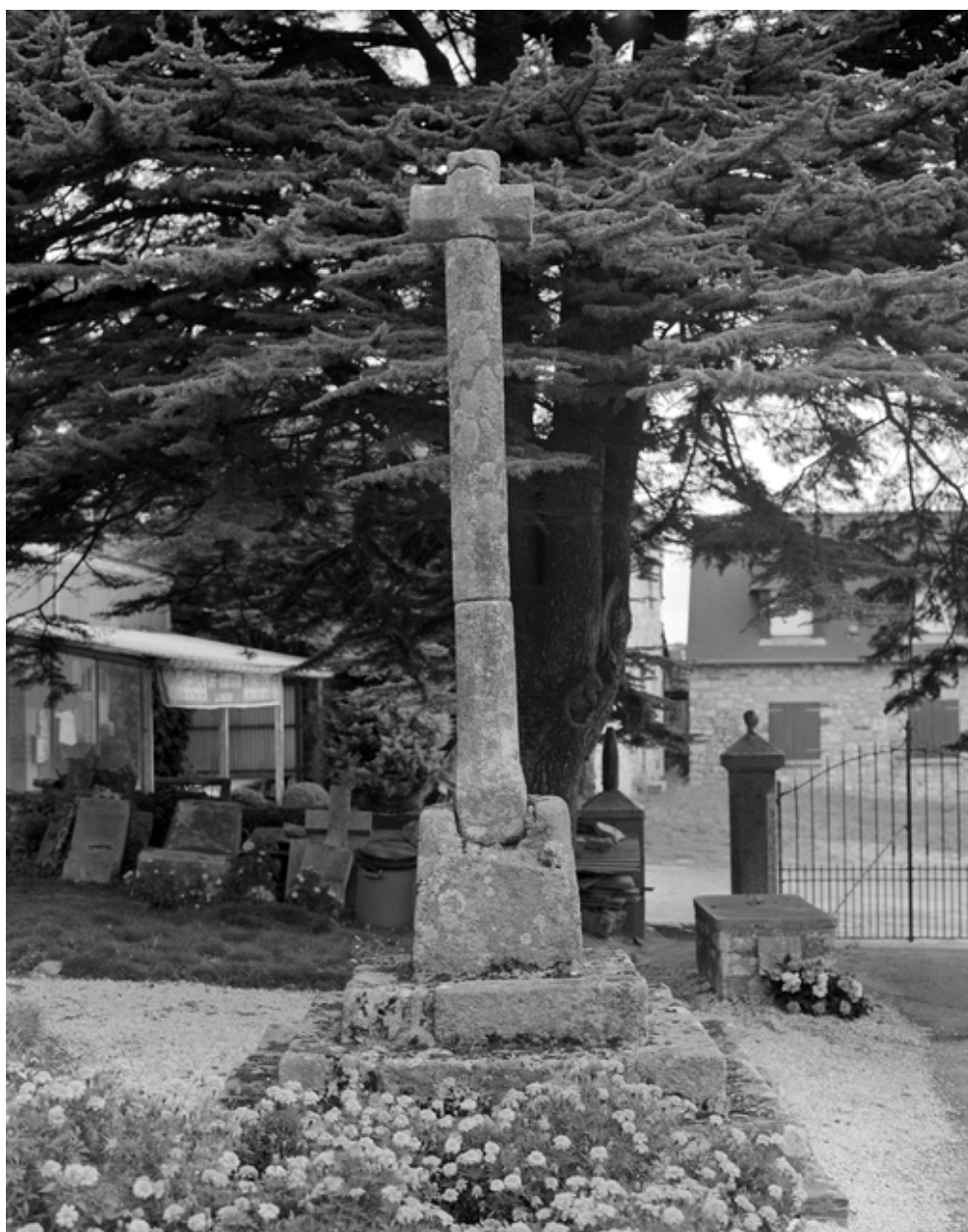
Croix monumentale, face ouest : vue générale
