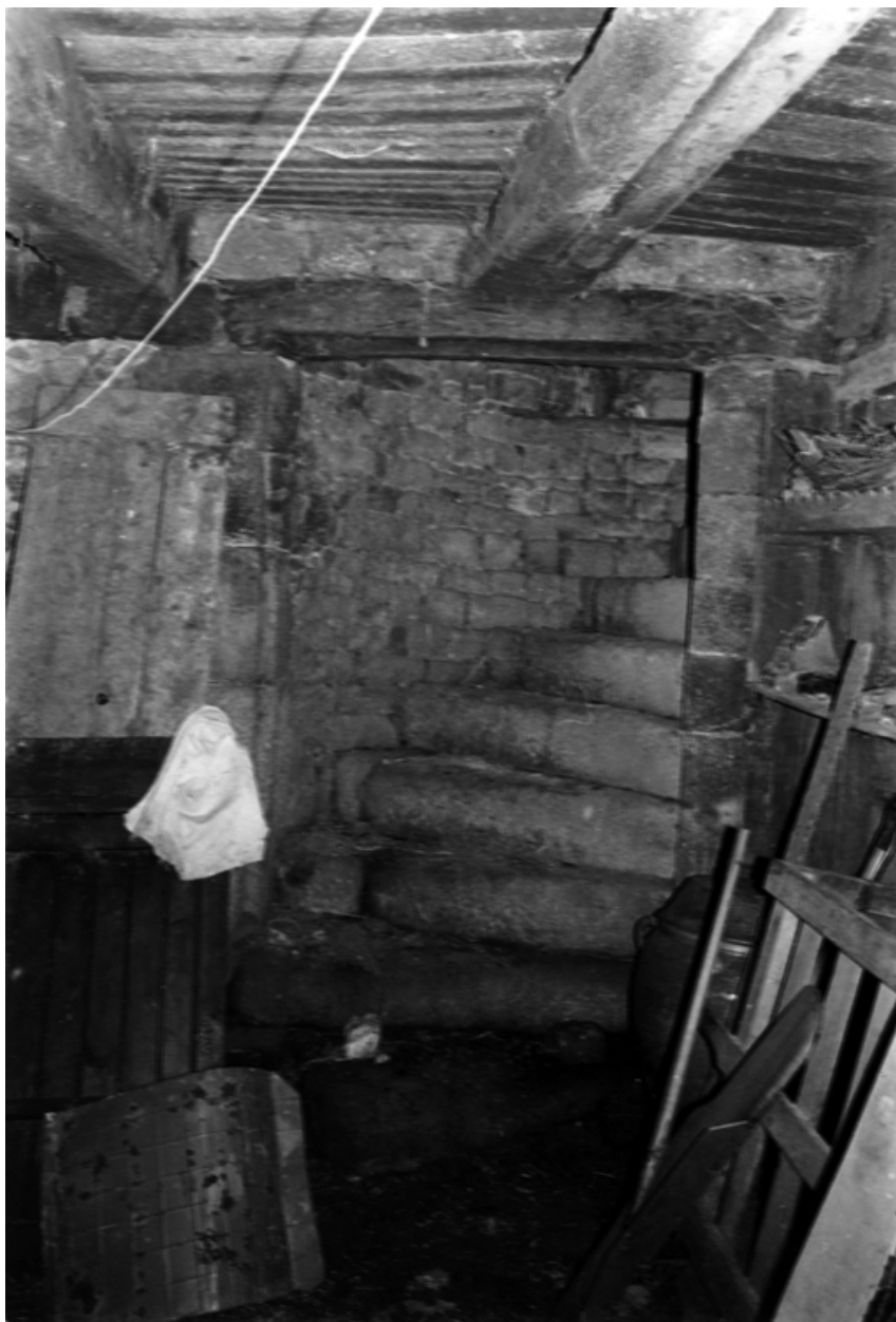
Maison A (Kerjulou) : vue de l'escalier
