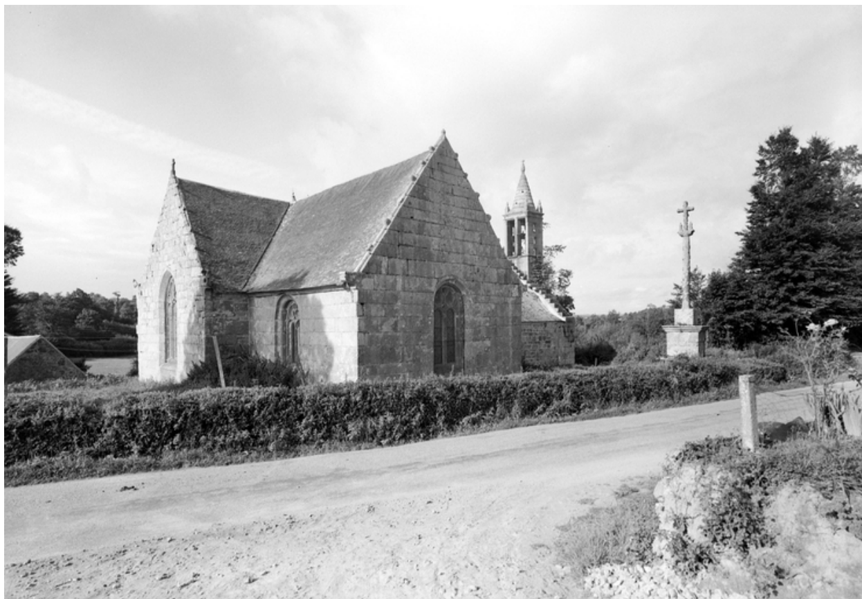
Vue d'ensemble nord-est
