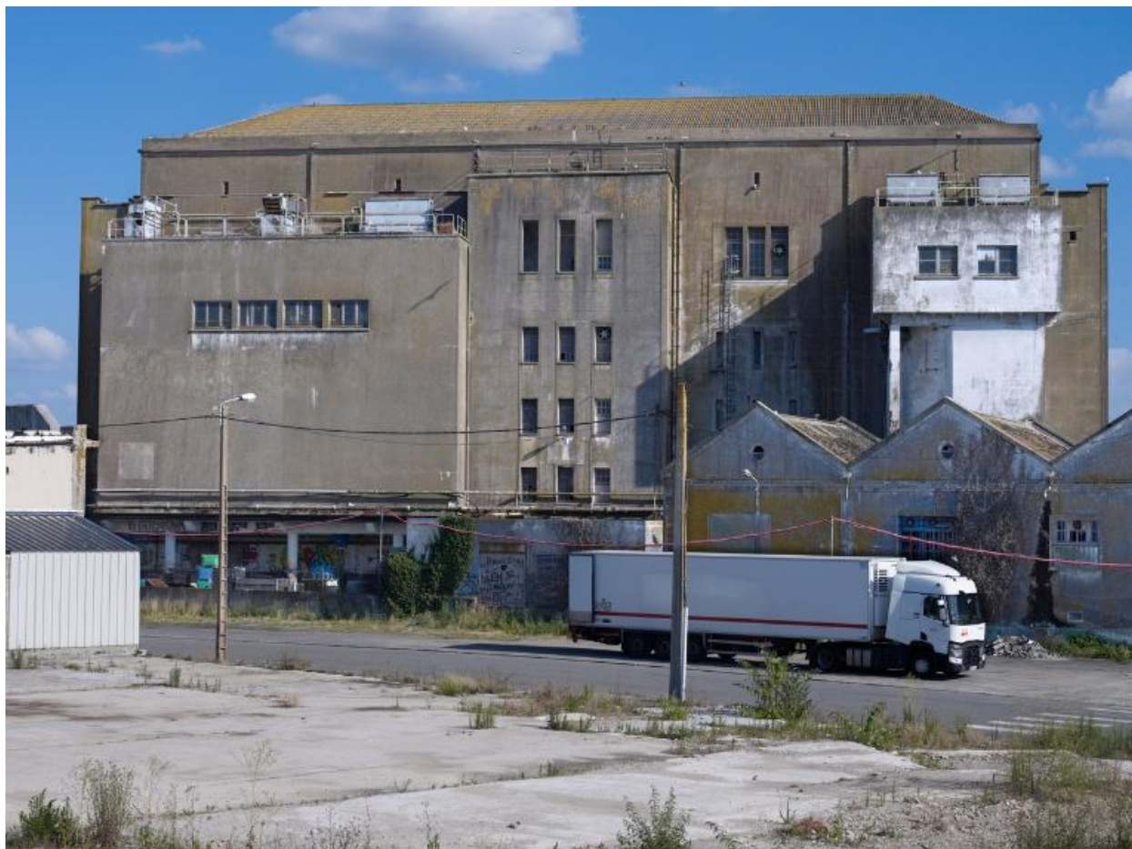
Frigorifique de Keroman, vue générale
