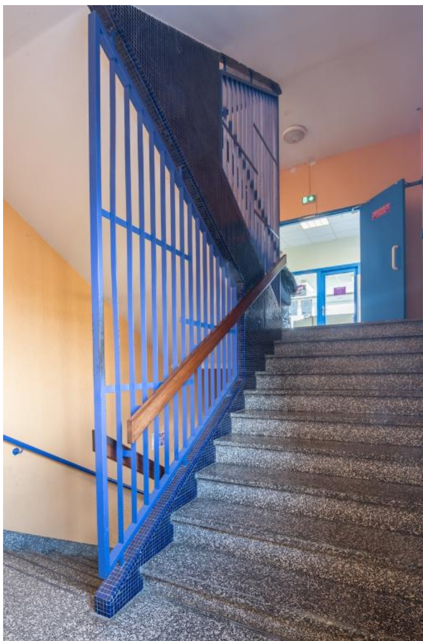
Cage d'escalier, bâtiment F, internat, actuellement internat externat. (Albert Hec et Roger Besnard, architectes, 1969)
