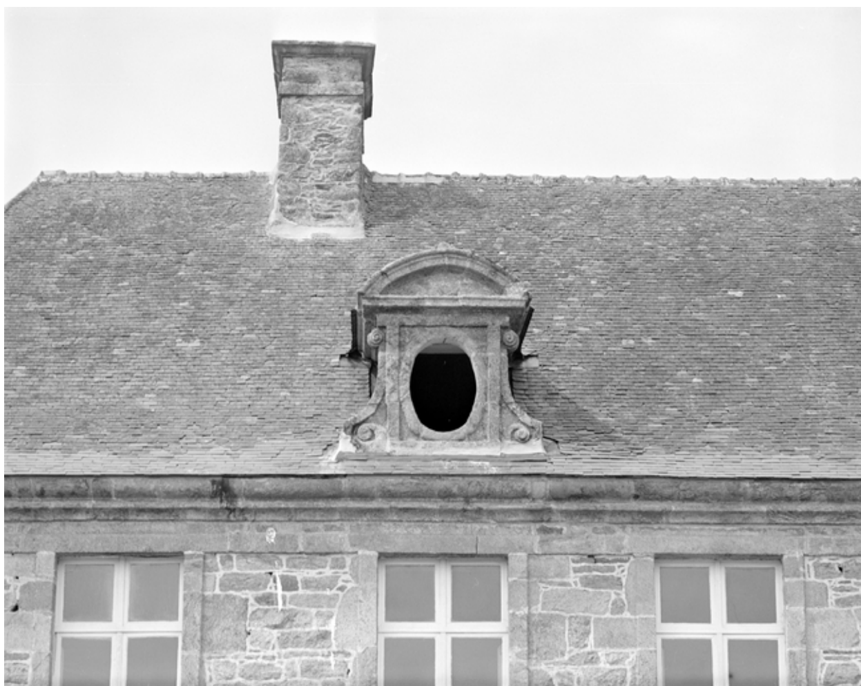
Détail d'une lucarne
