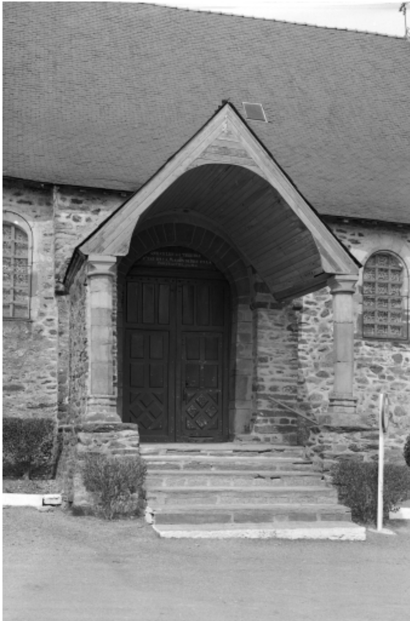
Façade sud, porche, vue générale.
