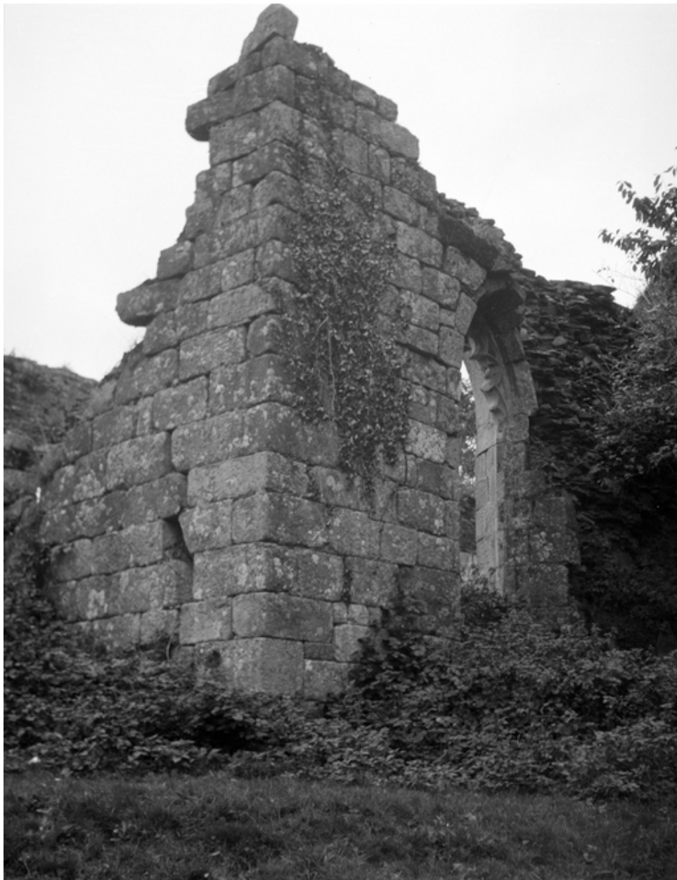
Vue de l'angle sud ouest de la nef : photographie prise vers 1955
