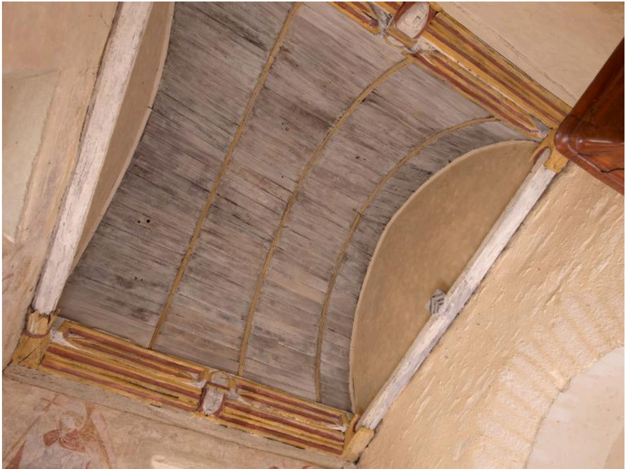
Eglise Saint-Melaine, vue intérieure de la charpente de la sacristie Saint-Gilles
