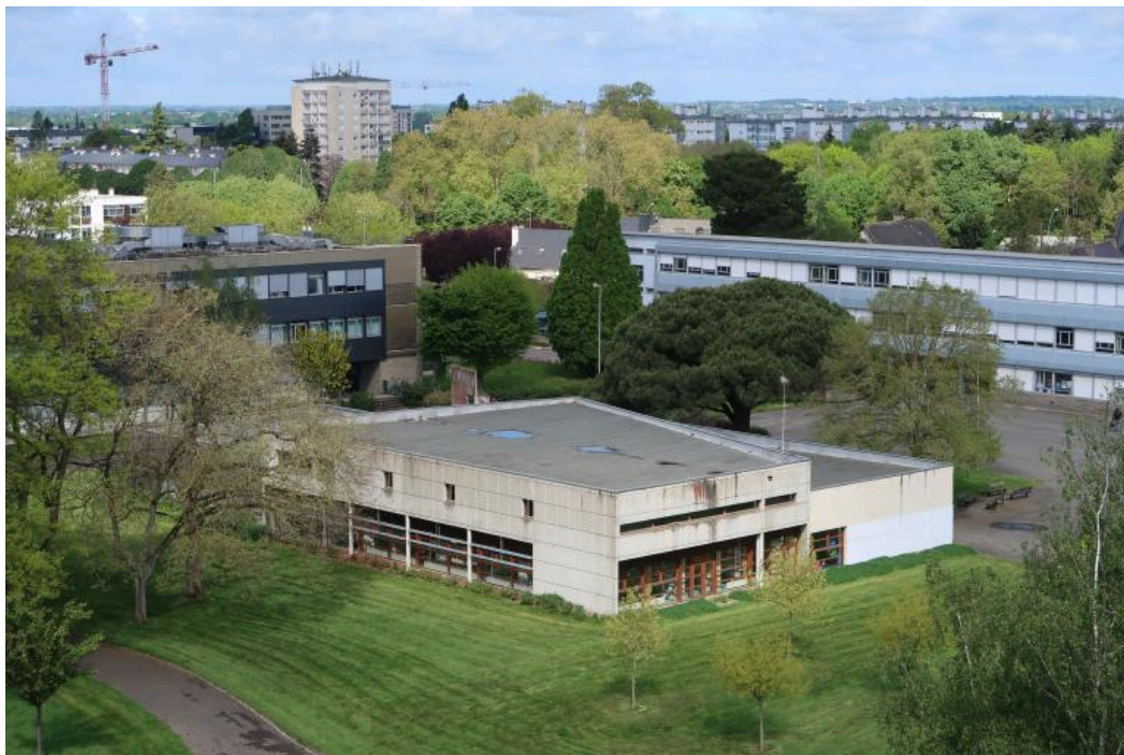
Vue d'ensemble prise du sud-est. Au premier plan, le CDI (E). A gauche, l'externat sciences (C). A droite, l'externat (D)
