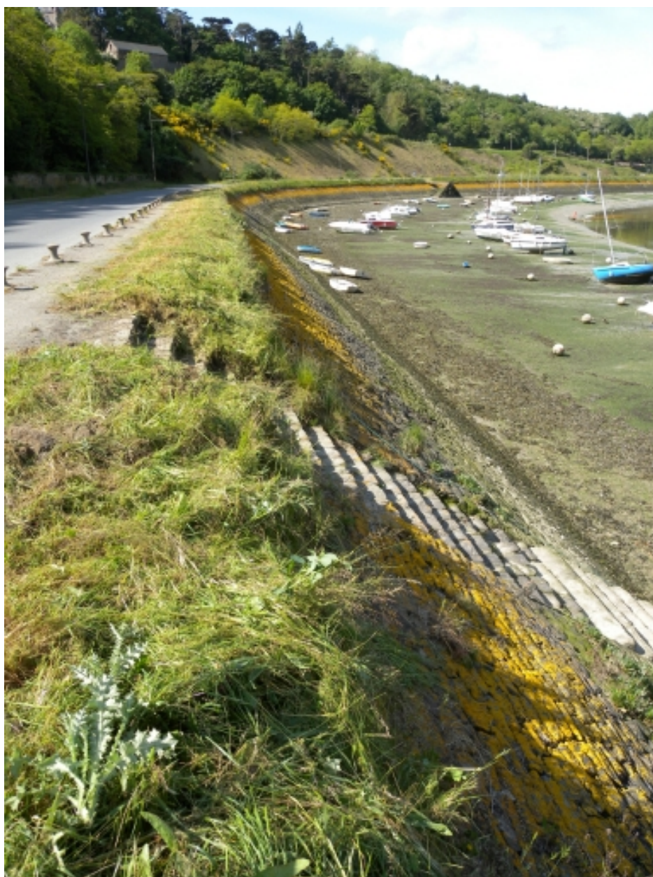
Vue des escaliers de desserte du mur de quai, rive droite
