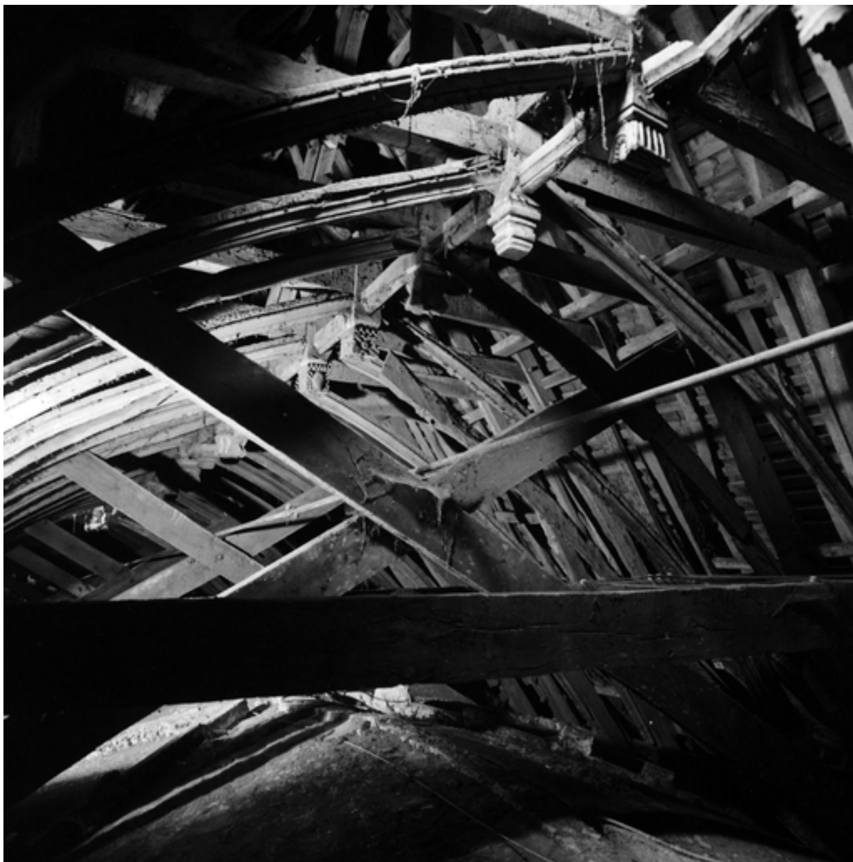
Vue de la partie inférieure de la charpente.
