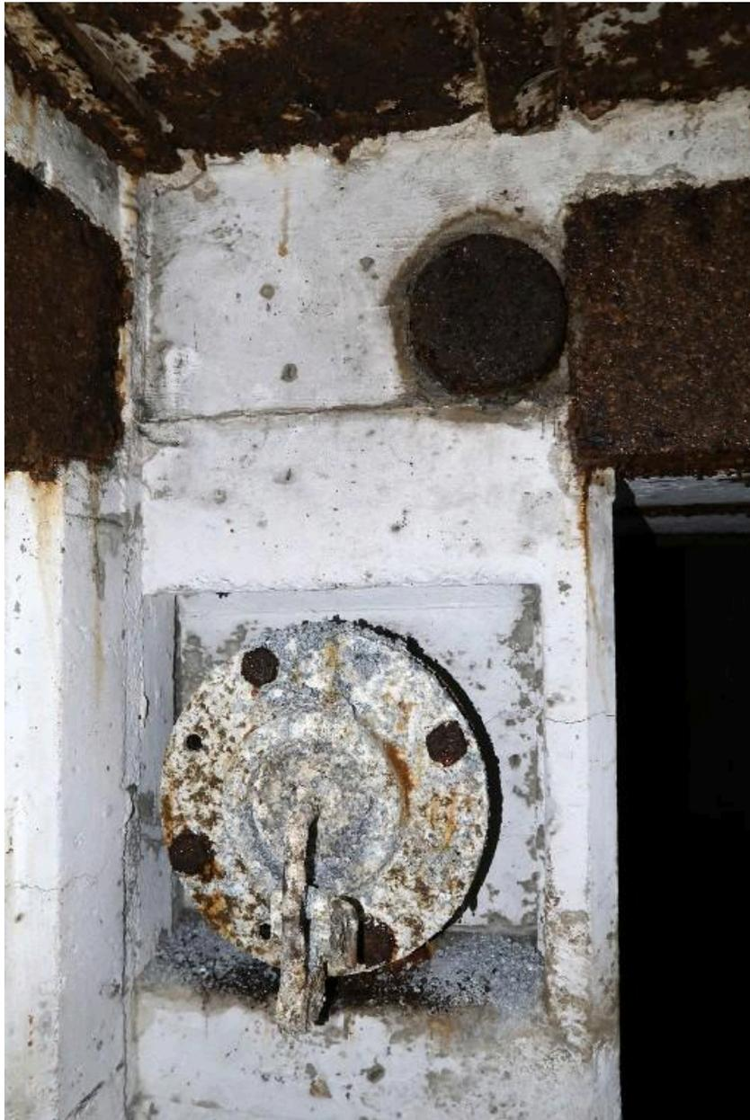
Vue du sas : mur ouest avec bouche de surpression à clapet à contrepoids en aluminium
