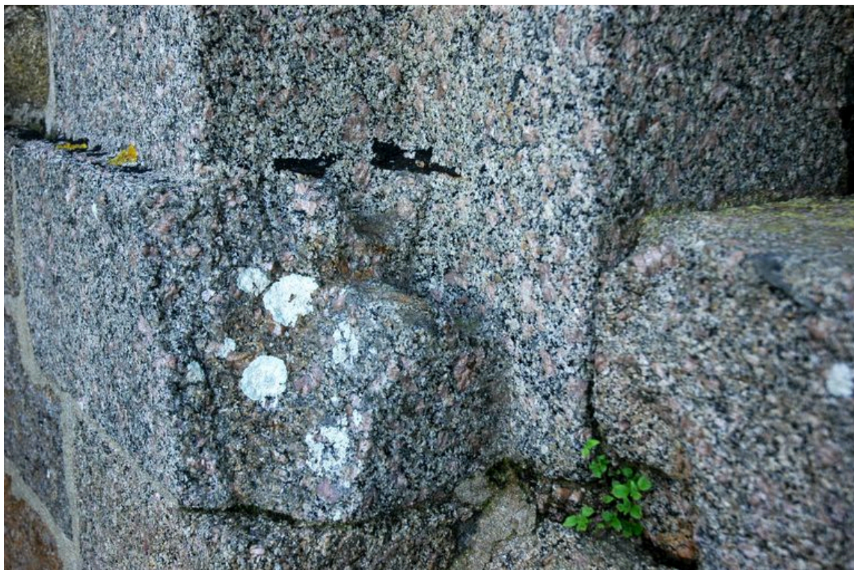
Elévation Est : détail du pivot du pont-levis basculant
