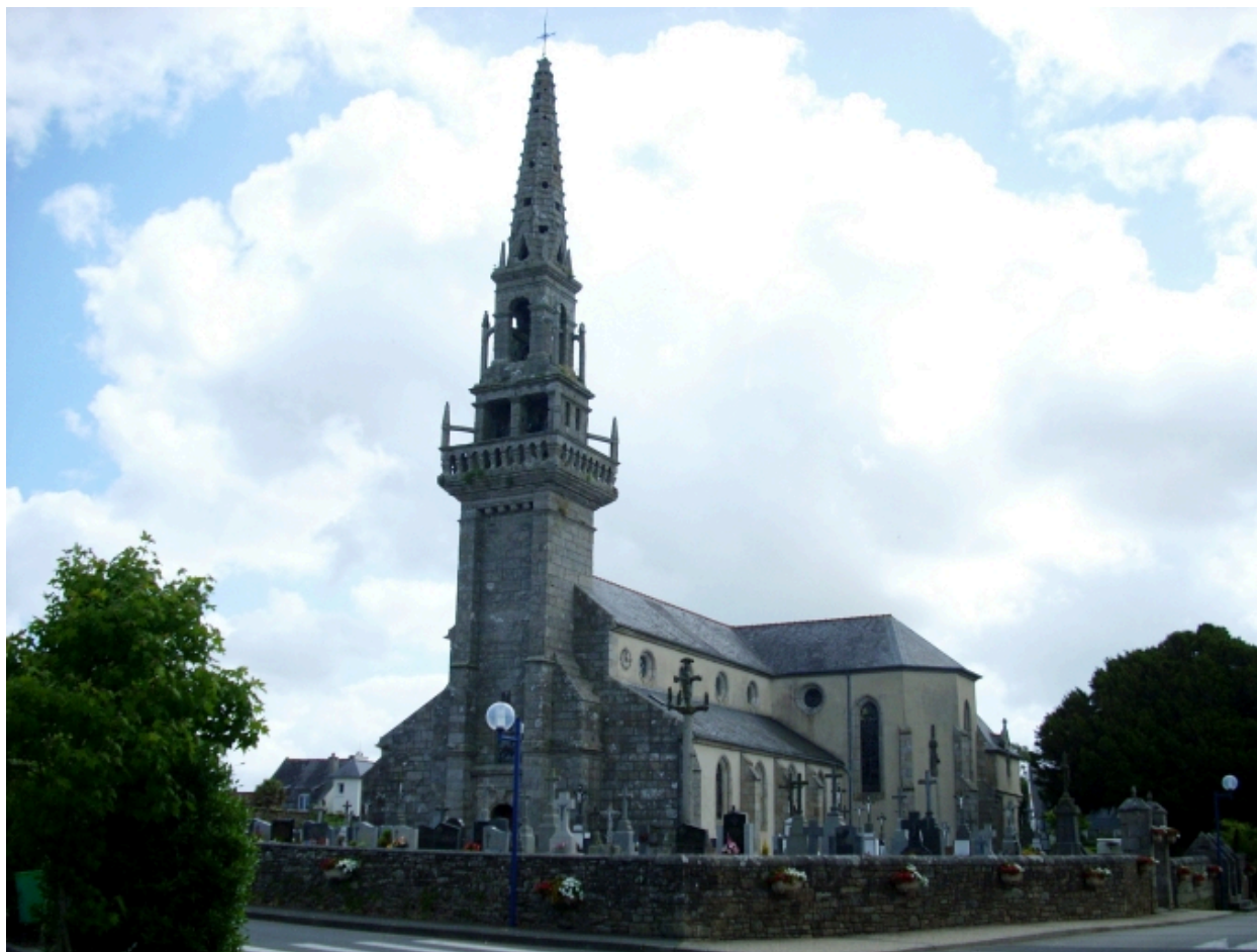
Kernilis, église paroissiale : vue générale sud-ouest
