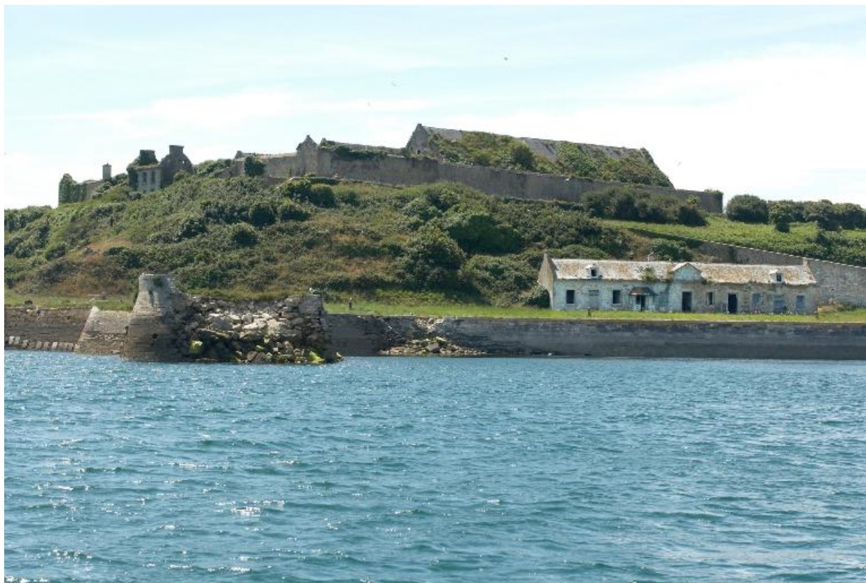
Crozon, île des Morts : ensemble de trois magasins à poudre et d'édifices logistiques
