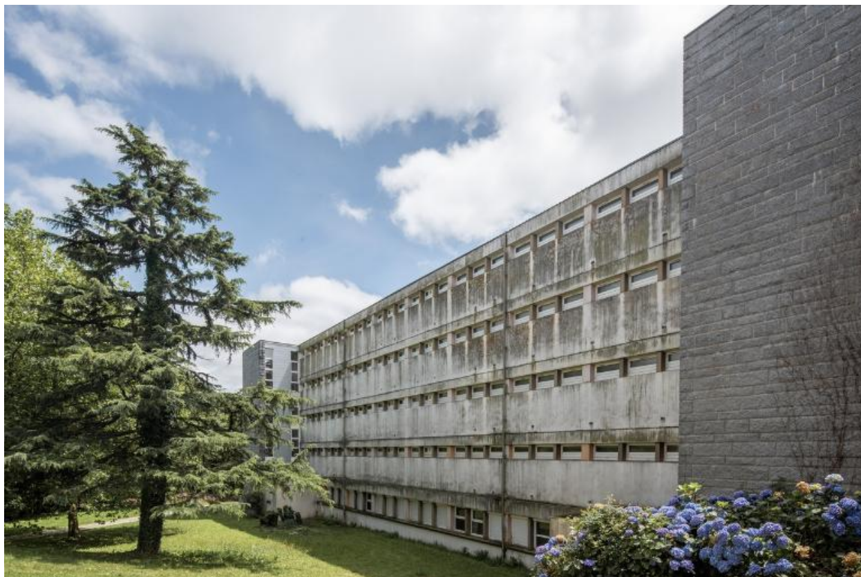
Internat des filles, façade nord. Péron et Weisbein, architectes, 1967-1968.
