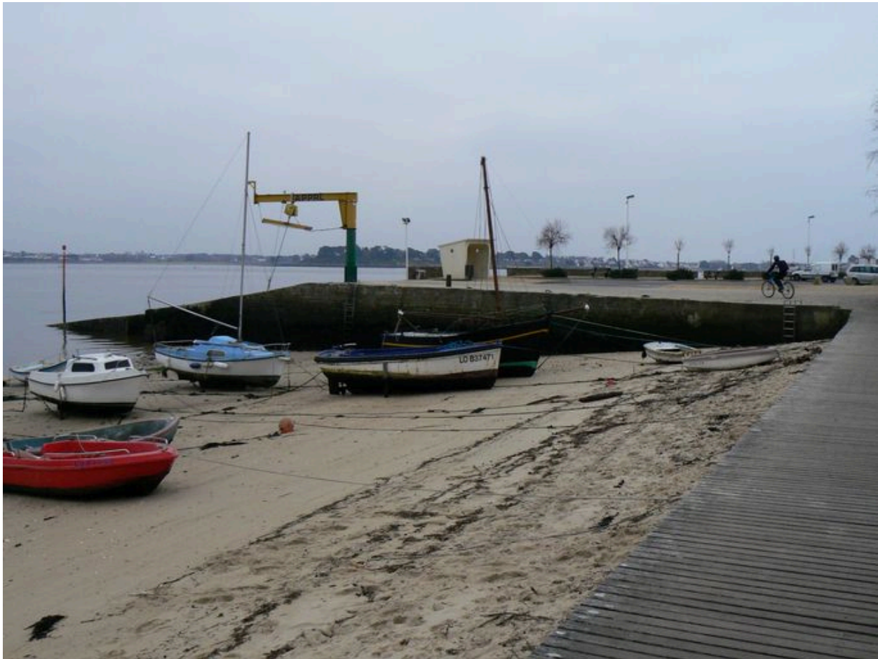
Vue générale de la cale de Kernevel
