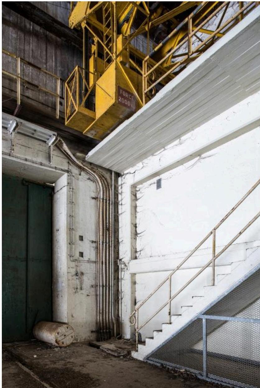
Vue du fond de l'alvéole nord (dans le renforcement du mur, la porte blindée nord) : escalier donnant accès au premier étage. Sur le mur, le réseau électrique d'origine. Peint en jaune, le pont roulant Levman d'une capacité de 2 t
