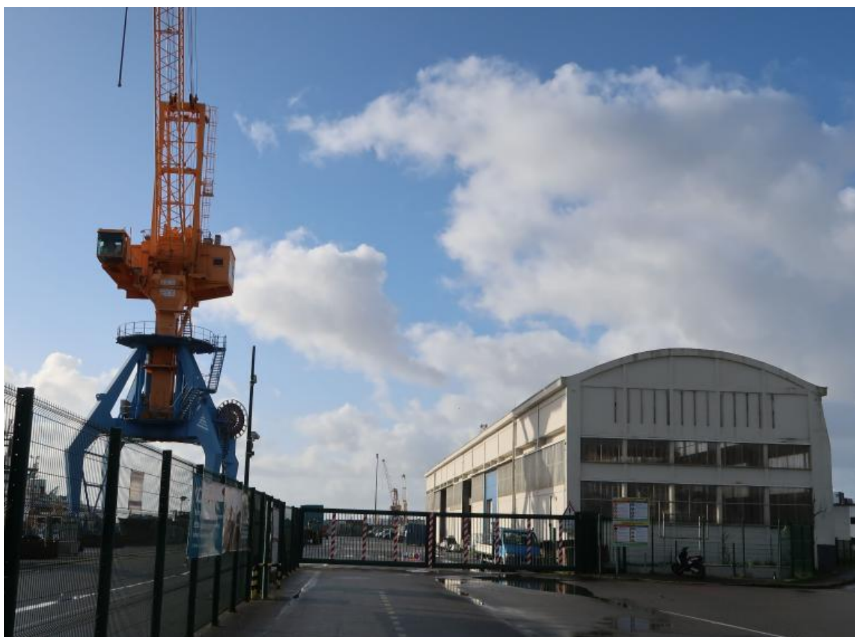
Hangar de réparation, ancien chantier Dubigeon, depuis l'Est vers l'Ouest
