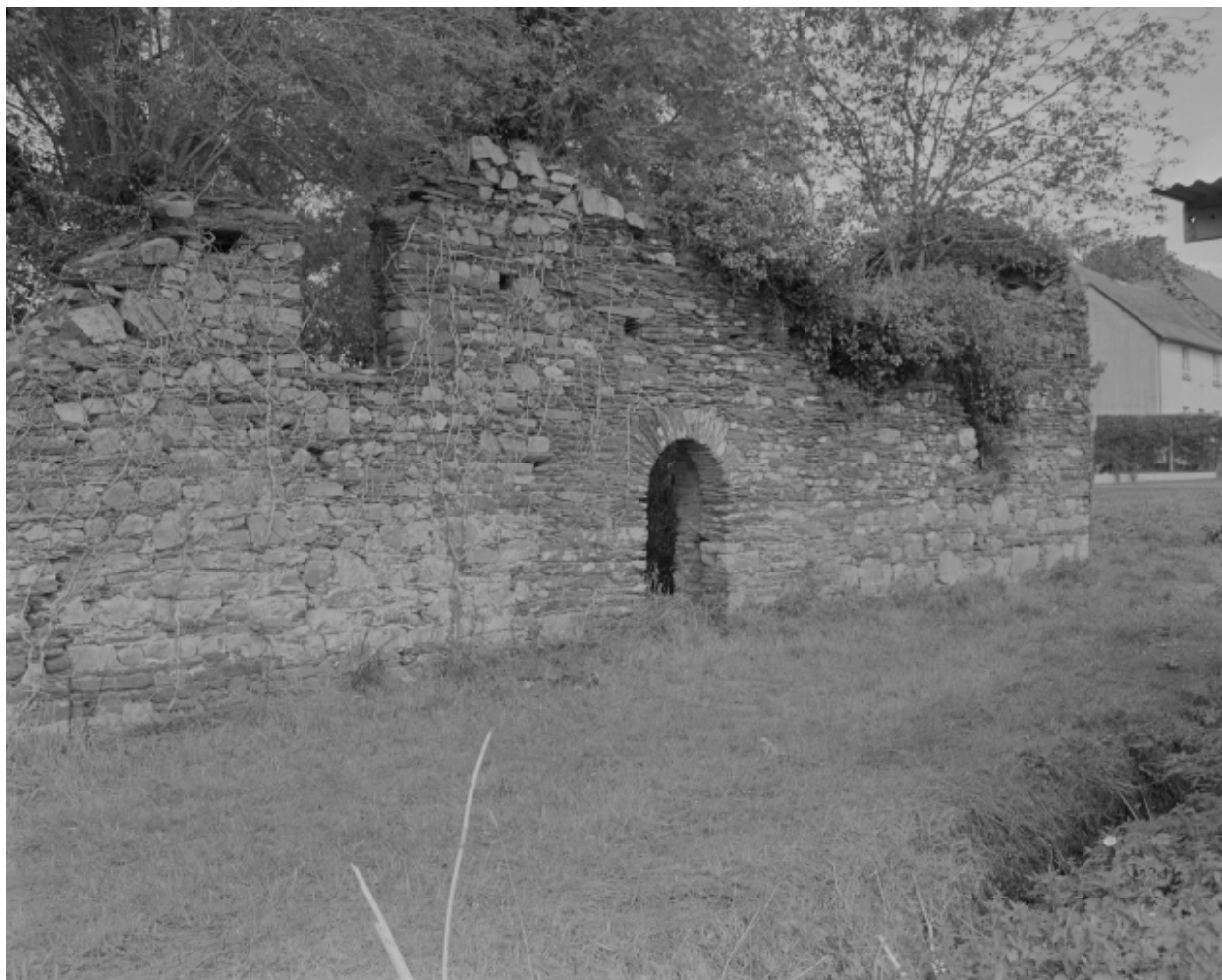
Elévation latérale : vue générale
