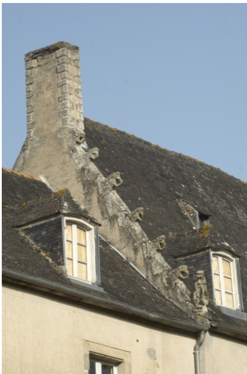
Logis, rampant du pignon
