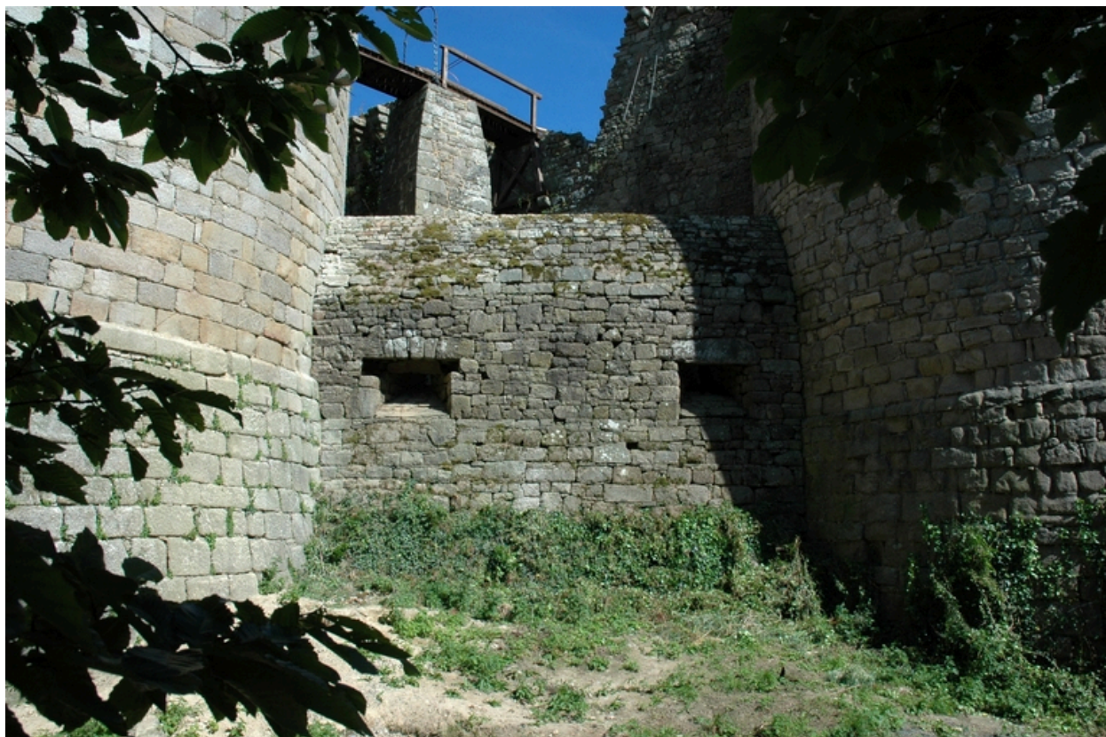
Vue de la courtine située entre la tour nord dite dite tour de Rougé et la tour nord-ouest (à droite)
