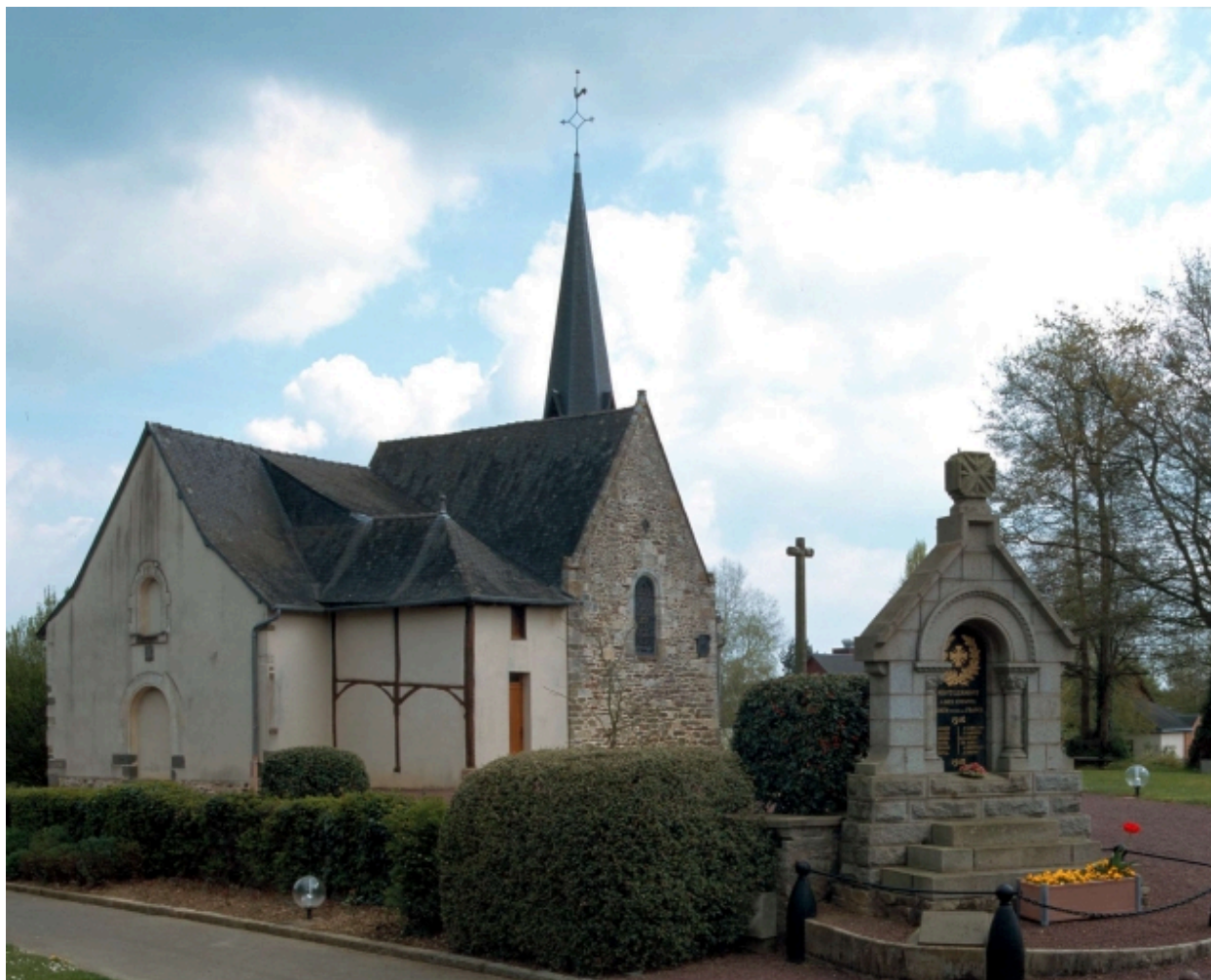
Vue générale, façades sud-ouest
