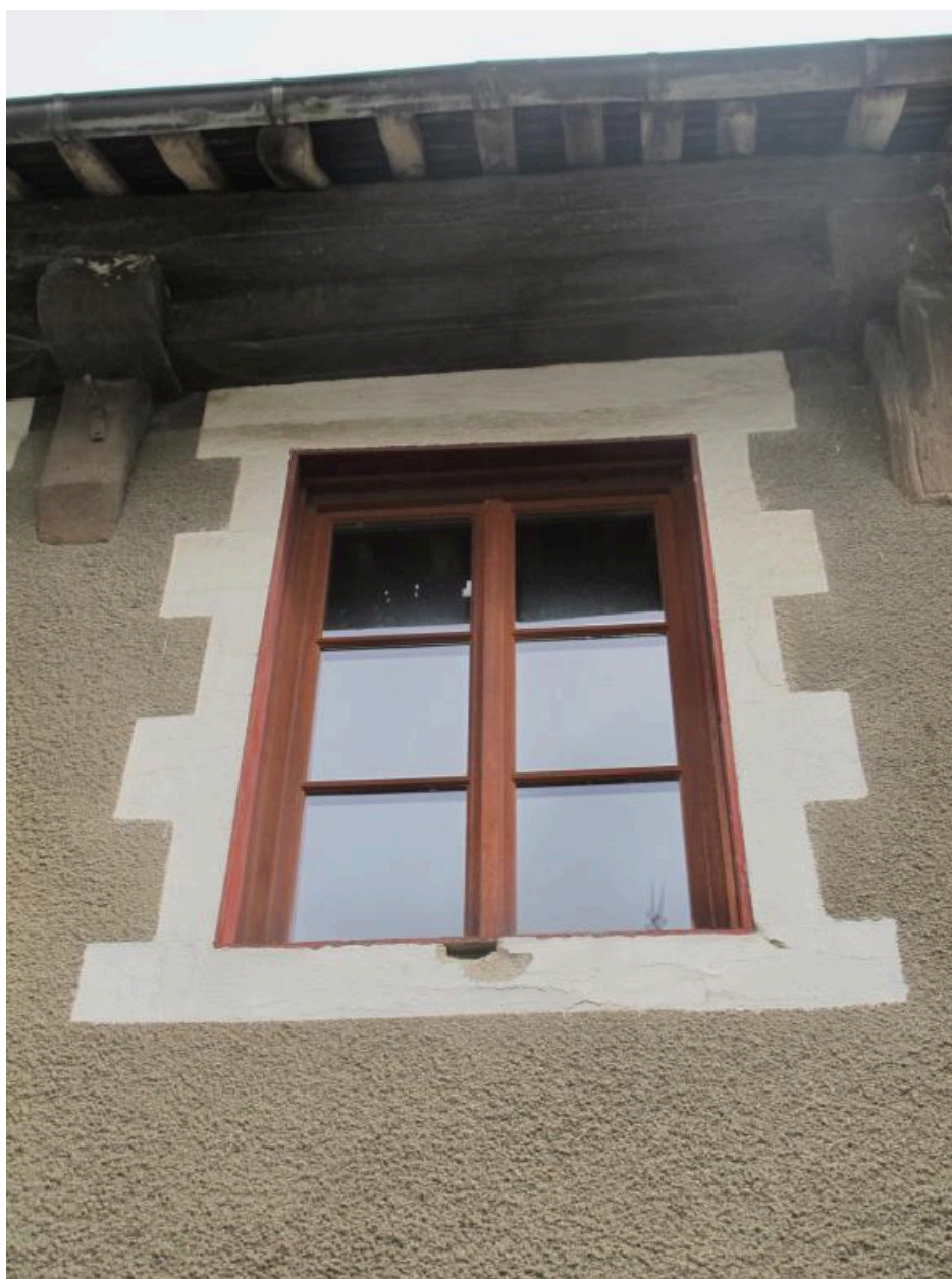
Façade nord. Premier étage, partie ouest, fenêtre
