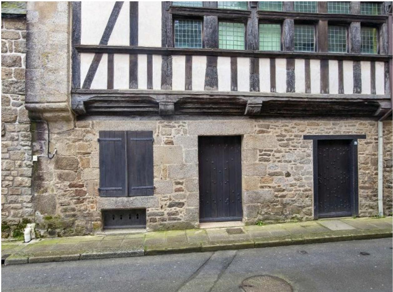
Façade de la rue au lait : le pan de bois en encorbellement est accompagné par le pignon maçonnerie en débord ; le rez-de-chaussée a été repris en sous-œuvre.
